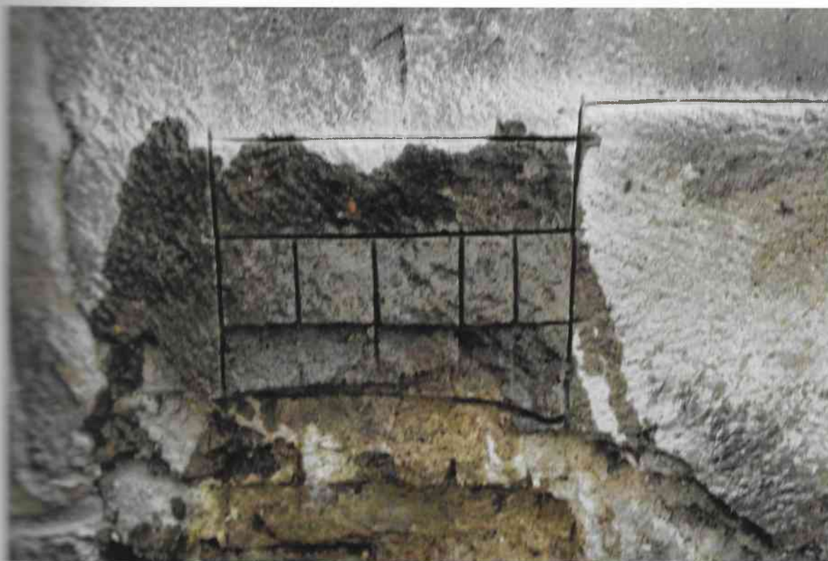
Zdjęcie - odkrywki nr 1 – Tynk wewnątrz portalu w płn. ścianie nawy
