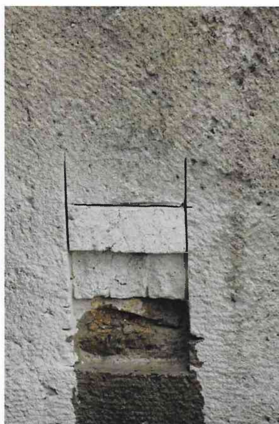
Zdjęcia - odkrywki nr 2 – Tynk wewnątrz portalu w ptn. ścianie nawy
