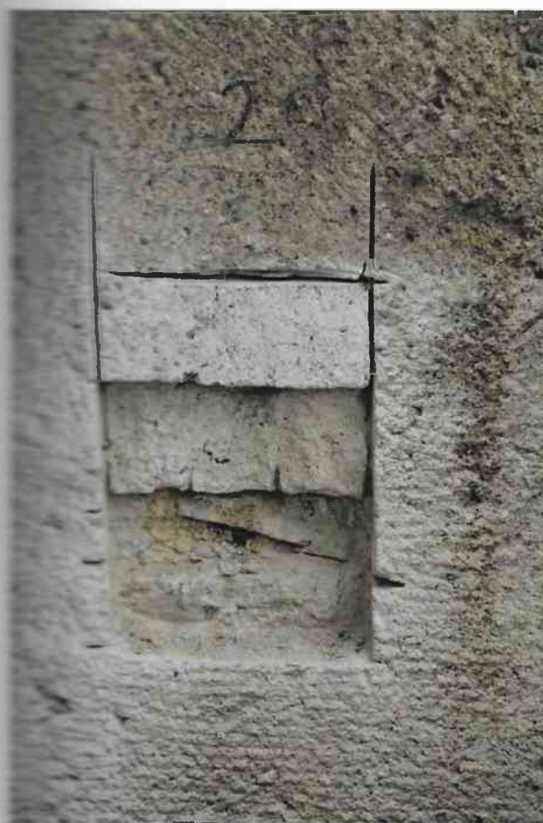
Zdjęcia - odkrywki nr 2 – Tynk wewnątrz portalu w ptn. ścianie nawy
